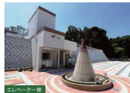
エレベーター棟
